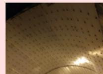
▲アンカーボルトにより固定された鋼板(ボルトの取付異常により落下が懸念)
