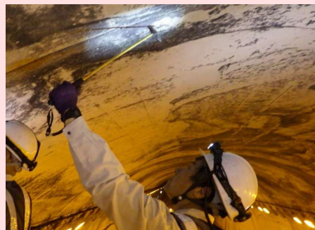
▲本体工の打音検査
