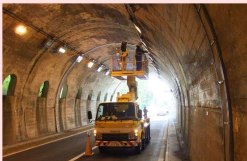
▲本体工の近接目視
