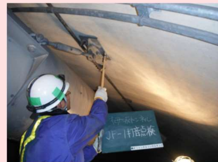
▲附属物の打音検査
