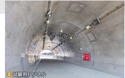
2 試験用トンネル
