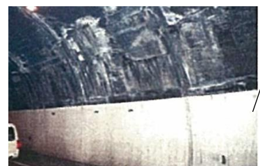
▲ 直接視認が困難な内装板背面
