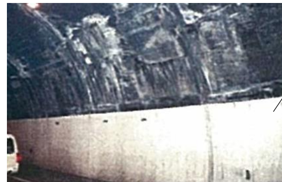
【内装板背面の覆工】
