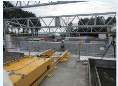
壁高欄の衝突試験状況
