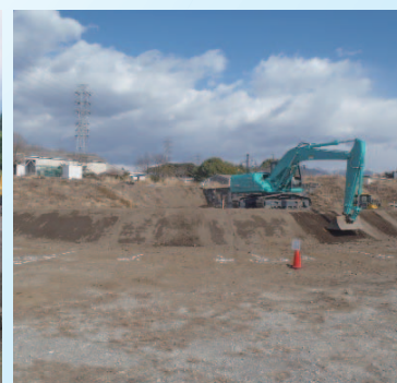
ICT施工に関する調査
