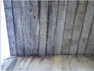
(b) 桁下面状況
