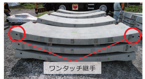
PCa部材 (リング間用ワンタッチ継手)
