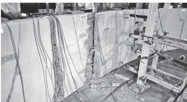
図一八 覆工コンクリートの破壊状況
