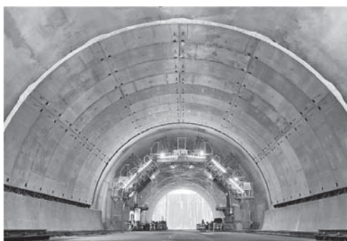
図-5 実証実験後の覆工
