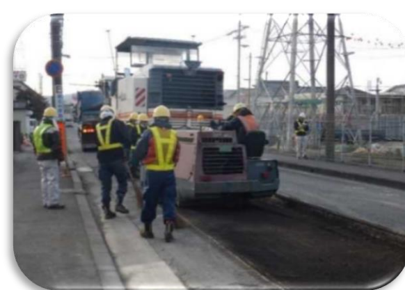
路面切削工 + 切削オーバーレイ工の路面切削
