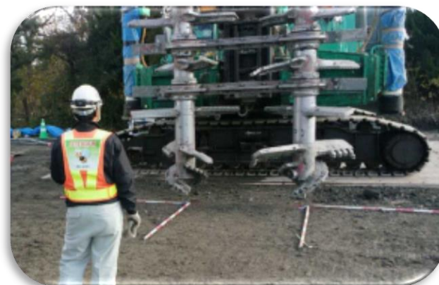
スラリー攪拌工
