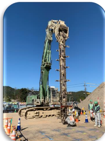
浅層・中層混合処理
