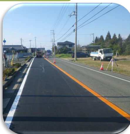
アスファルト舗装
