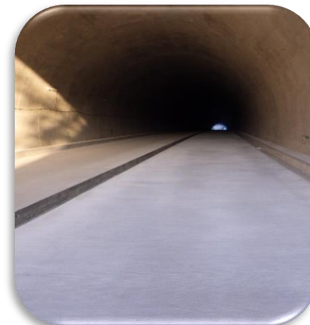
コンクリート舗装
