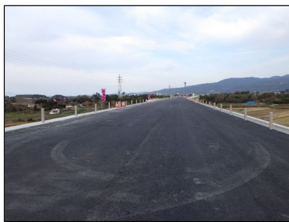
アスファルト舗装
