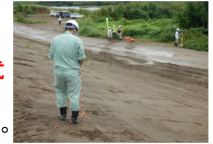
設計面と施工後の仕上がり面の高さの差を3次元的に確認
