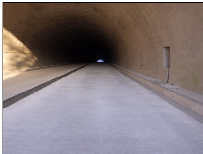
コンクリート舗装
