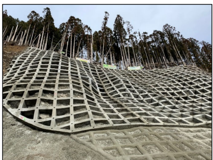
吹付け、法枠工
