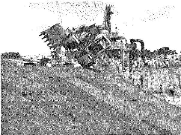
写真-2 油圧ショベル転倒時保護構造の性能基準策定
