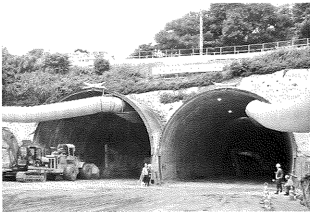
写真—4 豊見城トンネル
