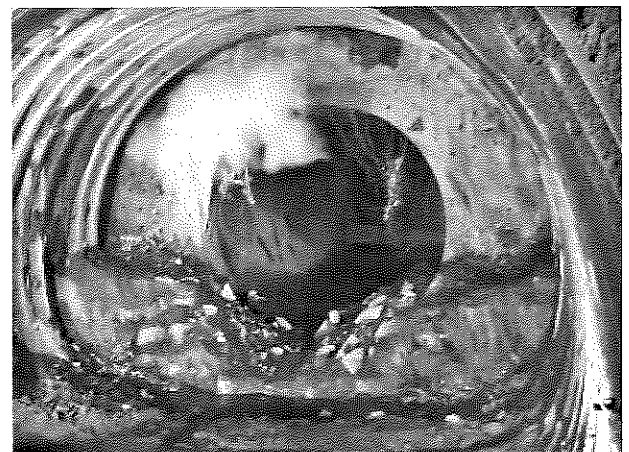
写真—7 安永川トンネル
