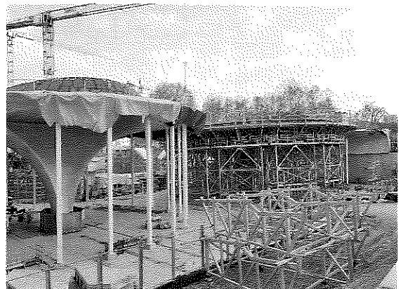
写真—37 中央駅舎の柱建設状況
