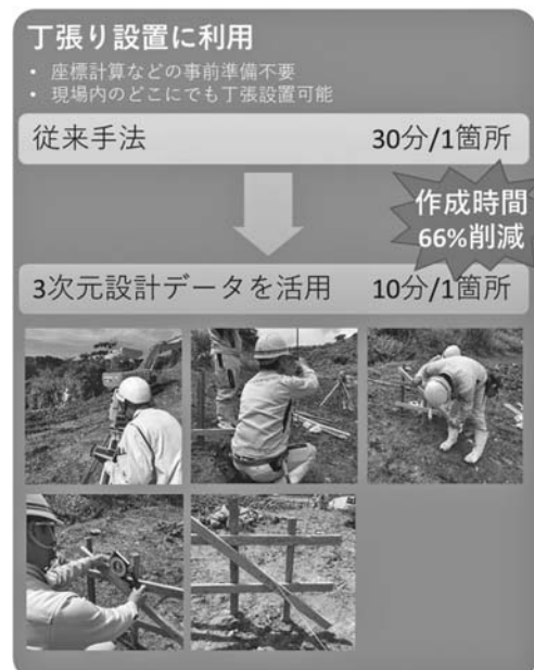
図—6 3次元設計データ活用例（丁張設置）
