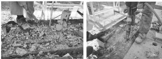
写真-5 後打ちコンクリートの加熱部の破砕
