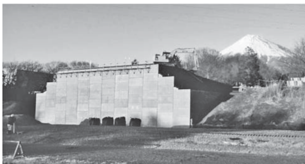
写真—1 当研究所の敷地内における補強土壁
