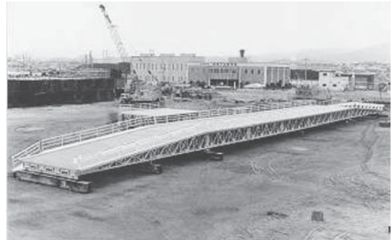
写真—1 応急組立橋（新潟防災センター） 1)
