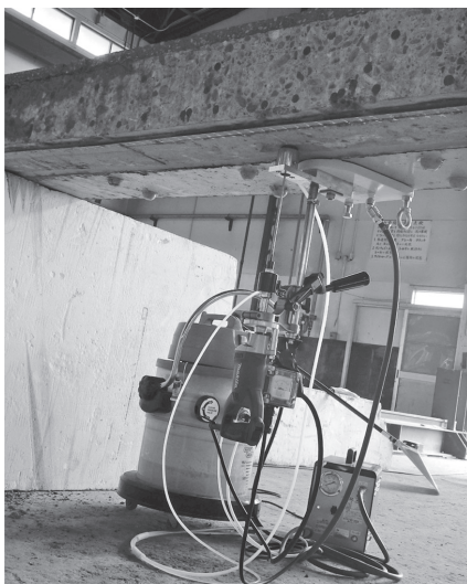
写真—10 下面からの削孔状況
