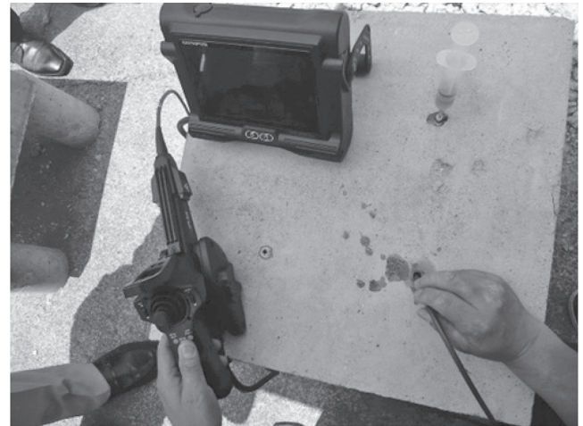
写真一 4 工業用内視鏡の調査状況
