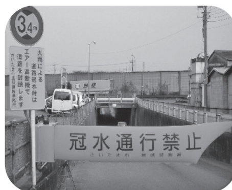
写真-7 エアー式自動交通遮断機
