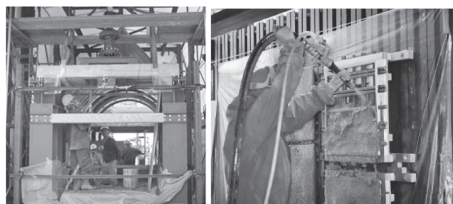
写真-5 吹付け材料の性能評価試験
