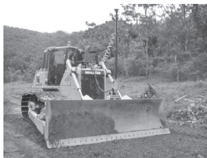
写真-2 情報化施工機器の設置状況(MCブルドーザ)
