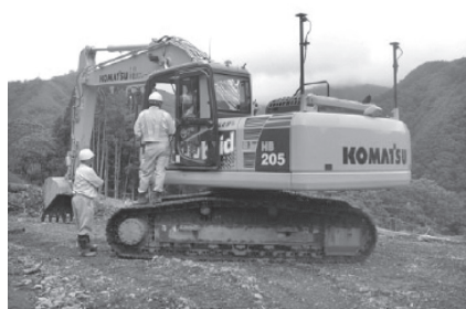
写真-1 情報化施工機器の設置状況(MGバックホウ)
