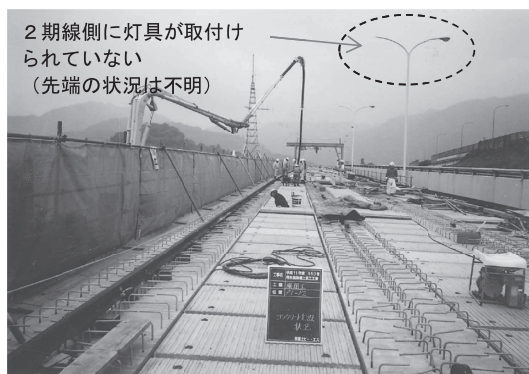
図一 2 2 期線工事状況写真 (工事期間:平成 12 年 3 月~平成 13 年 9 月)
