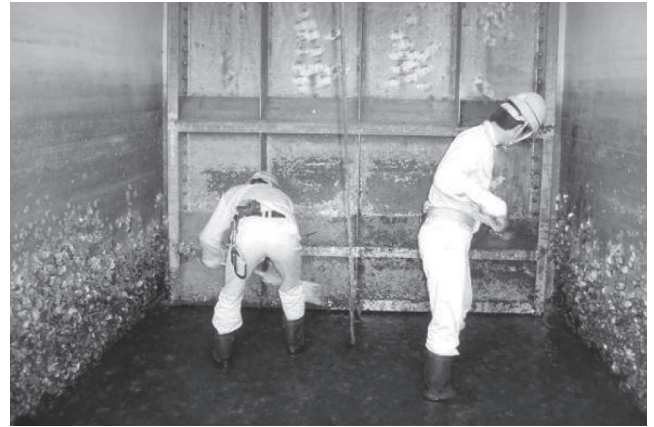
写真—2 付着した貝類の除去作業状況
