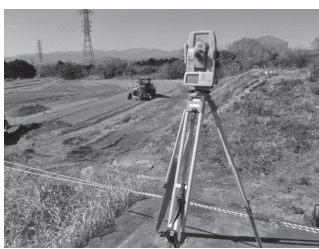
写真一四 MCによる敷均し高さ管理
