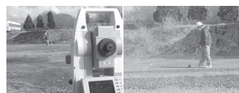
写真一 2 新たな管理基準による出来形管理 (路盤工)
