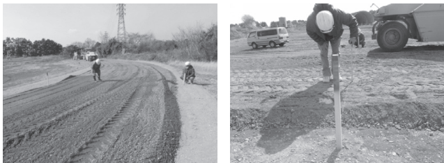
写真一三 現行の敷均し高さ管理
