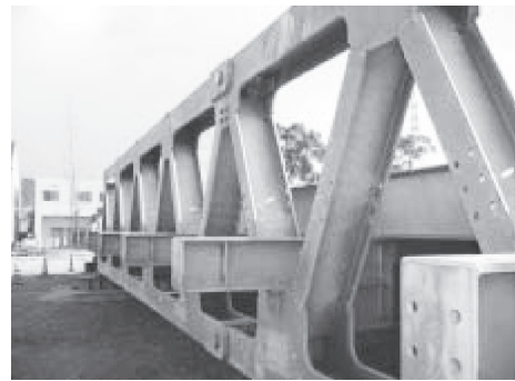
写真二 既往の応急橋の一例
