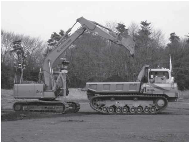
写真-3 自動掘削・積込みの基礎実験状況
