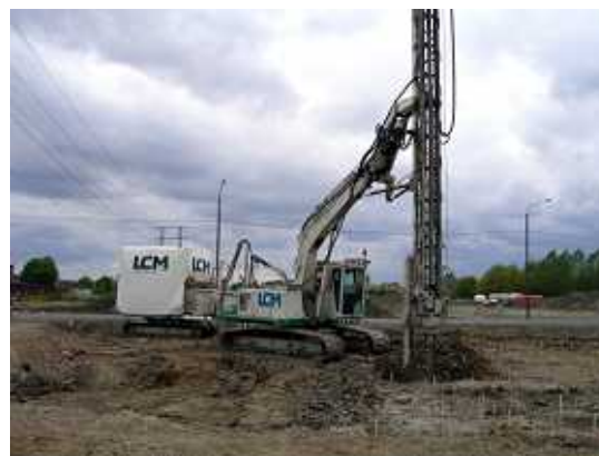
写真-2 北欧の粉体系施工機械の例
