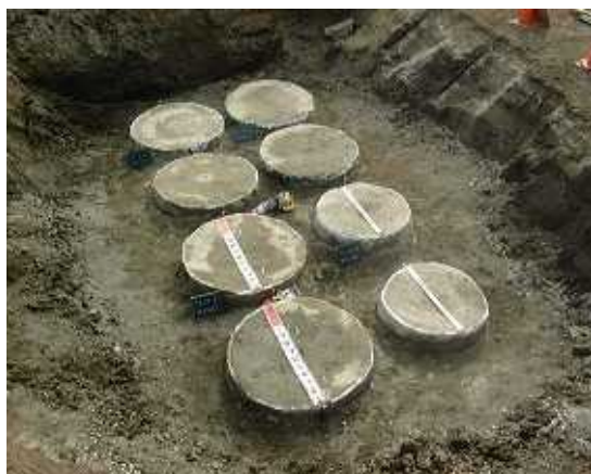
写真-4 大口径施工(手前: 1300 mm)の改良杭頭
