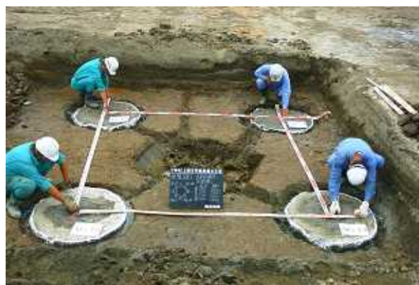
写真-5 高強度低改良率施工の改良杭頭
