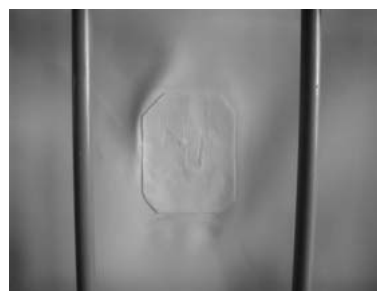
写真-4 補修状況
