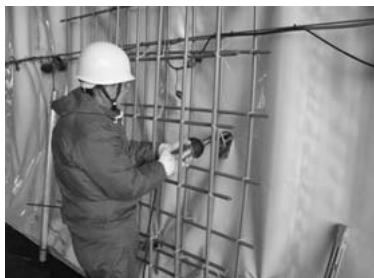
写真-2 補修作業状況
