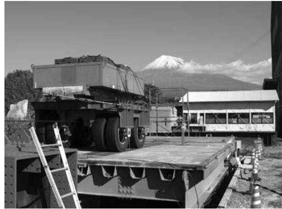
写真二 移動載荷疲労試験 (国土交通省より受託)
