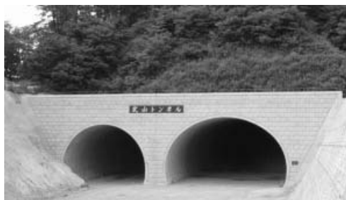
写真一4 坑門工完成後
