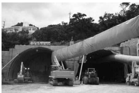
写真一5 識名トンネル坑口部
