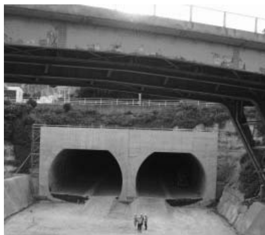
写真—2 坑門工完成後（ボックストンネルと接続）
