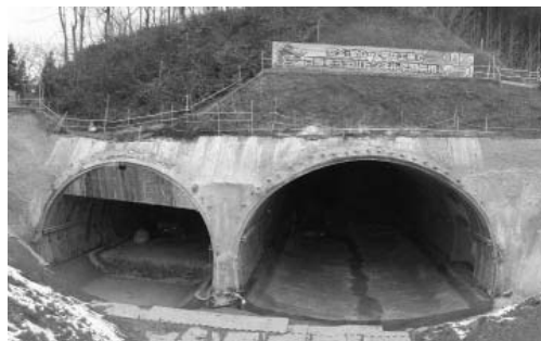
写真—3 北山トンネル坑口部
