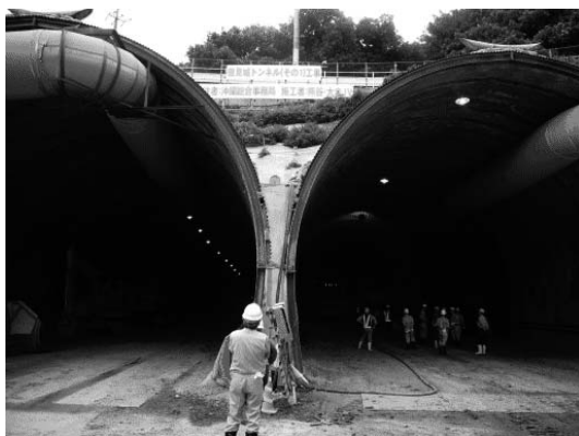
写真—1 豊見城トンネル坑口部
