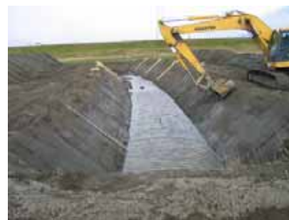
写真 1 丁張りレスのバックホウ作業
