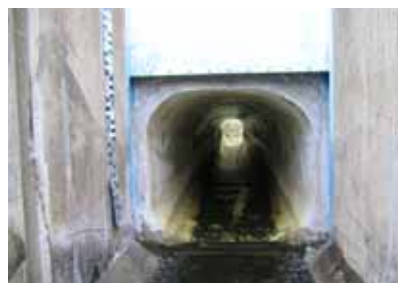
写真 - 1 管渠更生工法による樋管補修 （既設管口径：矩形 1.0×1.0m、更生材厚さ 36mm）
