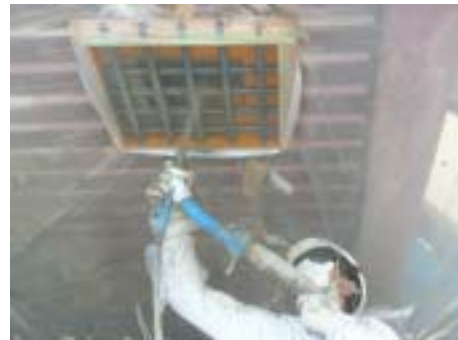
写真-3 鉄筋背面への充填性試験
