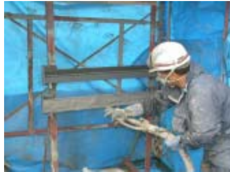
写真-2 ひび割れ抵抗性試験
