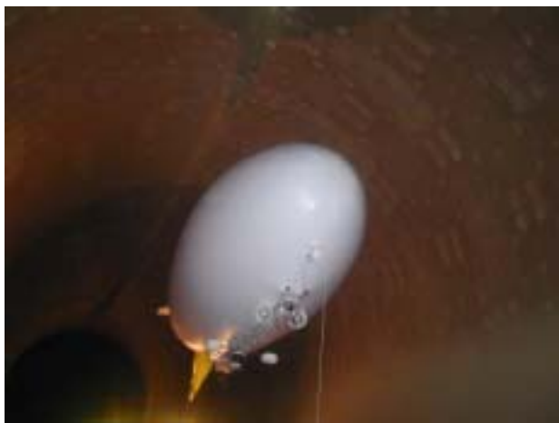
写真2 トンネル内自律飛行状況
