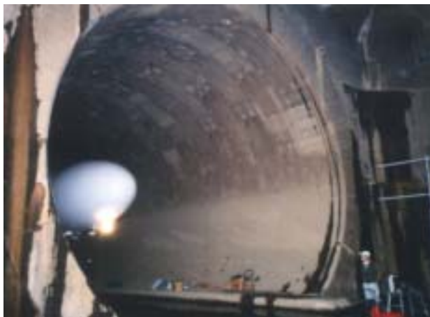
写真3 坑内約2km自律飛行の状況(到達立坑側)
