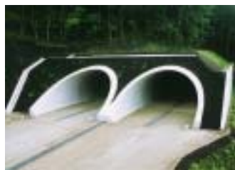
写真-1 めがねトンネル
