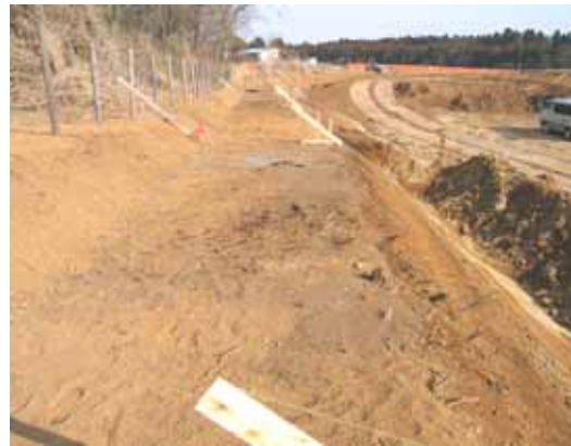
写真 - 2 現場丁張り設置状況
