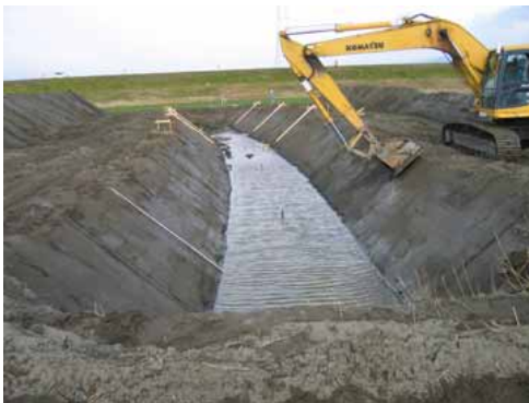
写真 - 1 丁張りレスのバックホウ作業
