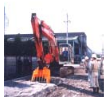
試験施工(写真-2) 写真-2 試験施工状況 を行った道路や公園駐
