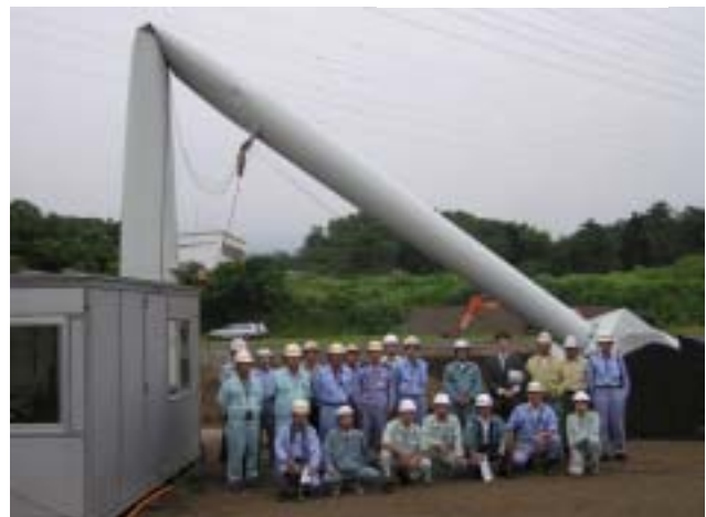
写真 - 5 倒壊状況
