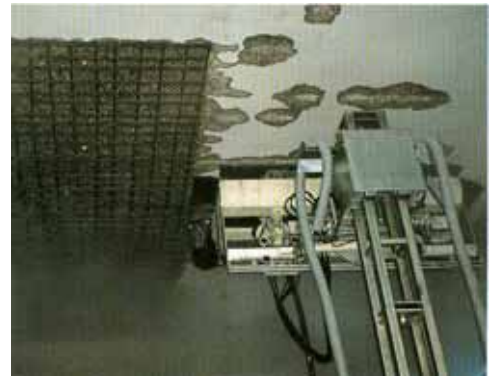
写真 4 現場施工状況
