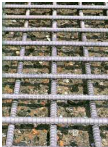
写真 3 鉄筋背面のはつり
