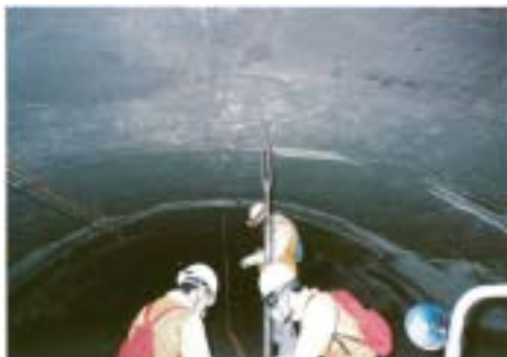
写真 1 関トンネル換気設備
