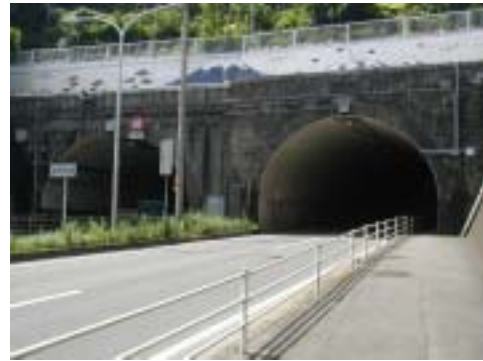
写真 2 横浜・横須賀トンネル
