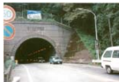
写真 3 岡部バイパス 宇津ノ谷トンネル
