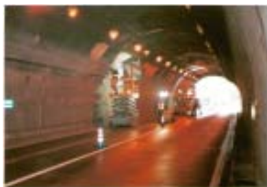
写真 4 42号小坂トンネル
