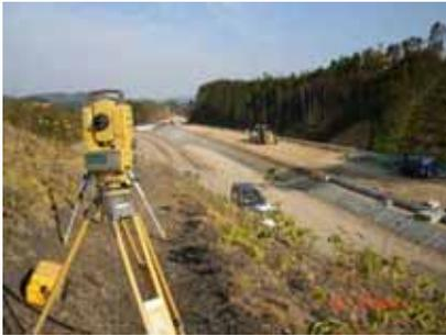
写真 - 1 情報化施工の路盤整正作業
