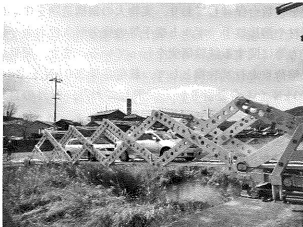
写真一五 緊急仮設橋の開発
