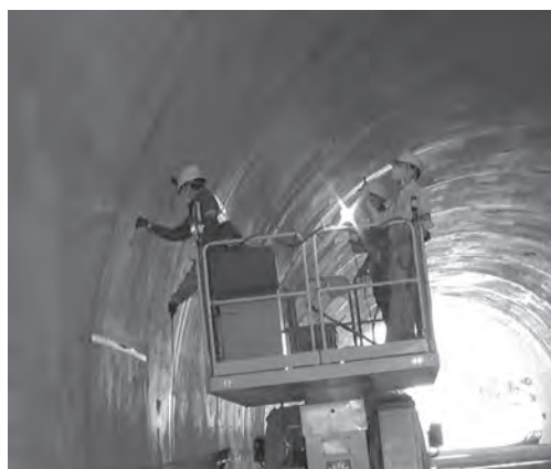
(a) 高所作業車による作業状況
