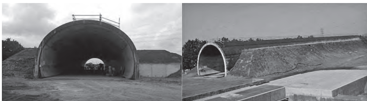
写真—3 模擬トンネルの外観
