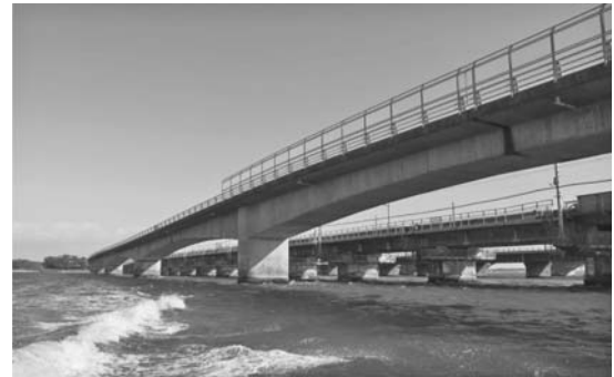
写真-5 競艇新大橋
