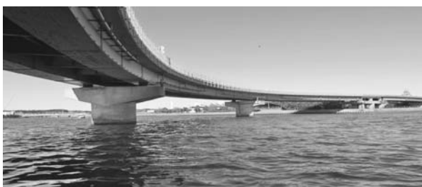
写真-4 第2勝鬨橋
