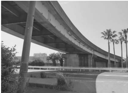
写真-1 新居跨線橋 (国道部)
