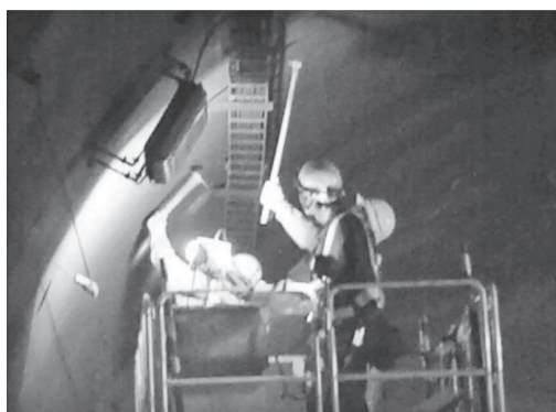
写真—3 打音検査の作業状況
