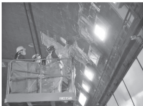
写真—2 近接目視の作業状況
