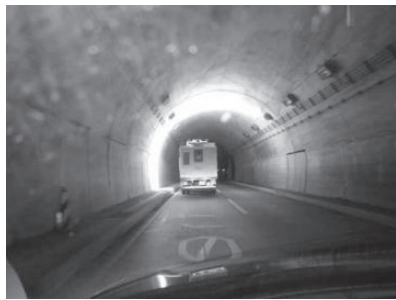
(a) 車両走行型検査技術その1
