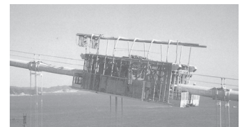
吊橋メインケーブル補修作業車
