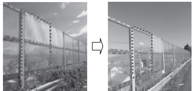
(a) 施工前 (b) 施工後
