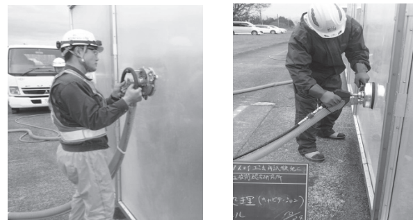
(a) WJ 工法 (b) CAB 工法
