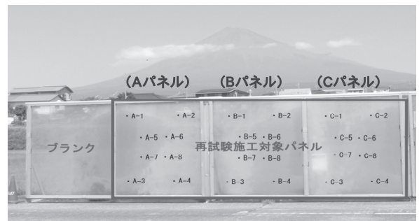
写真—5 実験対象の透光性遮音壁（記号は、パネル箇所と測定位置）
