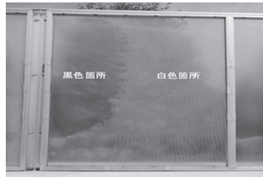
写真—1 透光板の劣化状況
