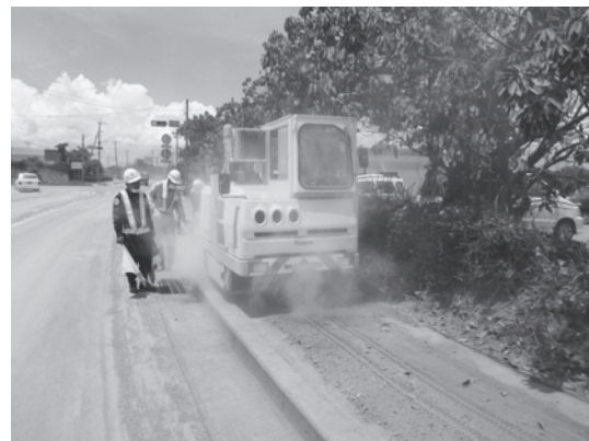
写真一1 現場踏査状況
