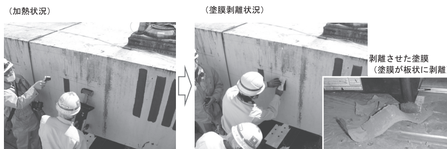
写真一2 塗膜除去試験状況
